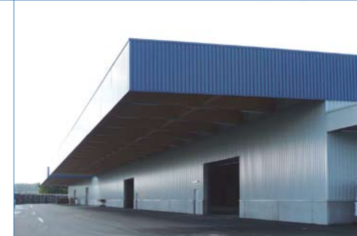
Tanto spazio per una grande forza di fornitura: il nuovo capannone-magazzino è lungo 171 m!
